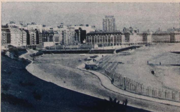
Para resolver los problemas vinculados con el abastecimiento de agua potable, Obras Sanitarias realizará trabajos por 1.600 millones de pesos.
